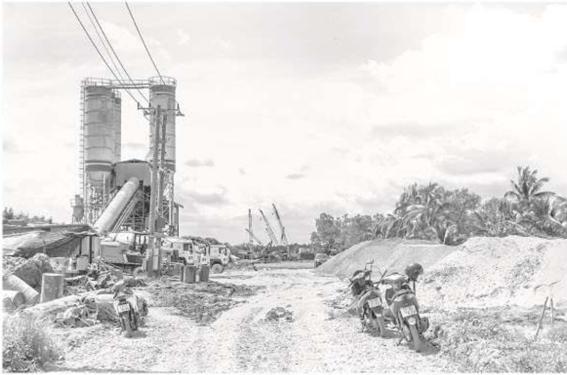
Công trường dẫn vào cầu Ba Lai 6 đang thi công, dự án có tiến độ giải ngân tốt, được tỉnh ghi nhận, biểu dương. Ảnh chụp ngày 24/10.
