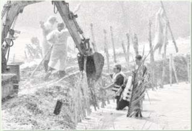
Lực lượng tham gia diễn tập huy động nhân lực, phương tiện gia cố đê bao, xử lý tình huống sạt lở tại ấp Xoài Lơ.
