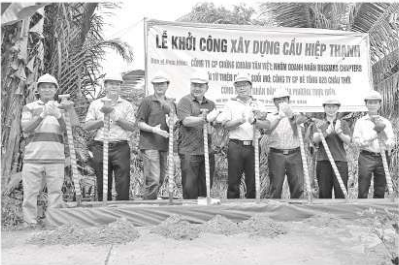
Đại biểu thực hiện nghi thức động thổ khởi công công trình.
