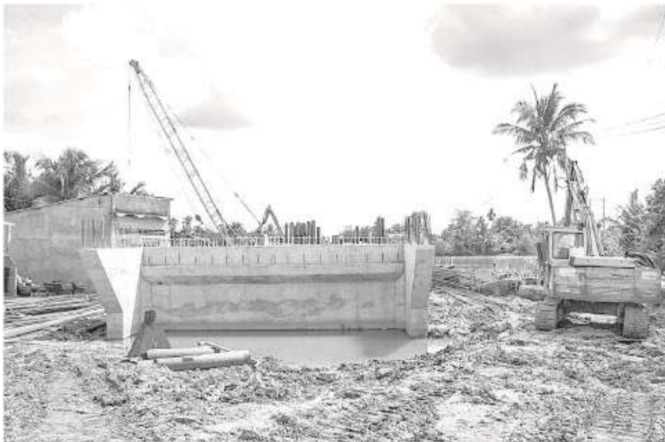
Thi công Dự án Xây dựng cầu Đông Kinh phía xã Hưng Khánh Trung.
