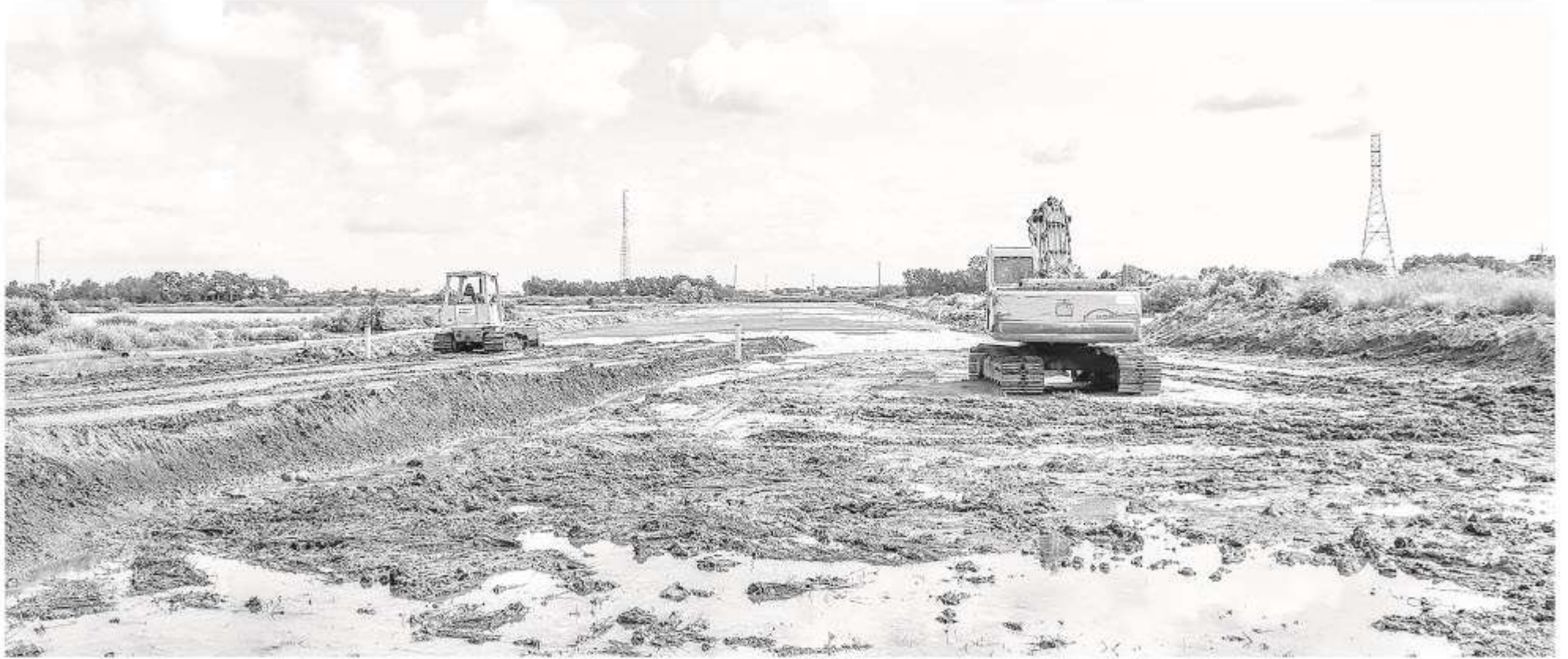
Gói thầu số 01 xây dựng 9,5km đường và các cầu số 1, số 2, số 3, số 4 thuộc Dự án cầu Ba Lai 8, đang được nhà thầu mới thi công khẩn trương.
