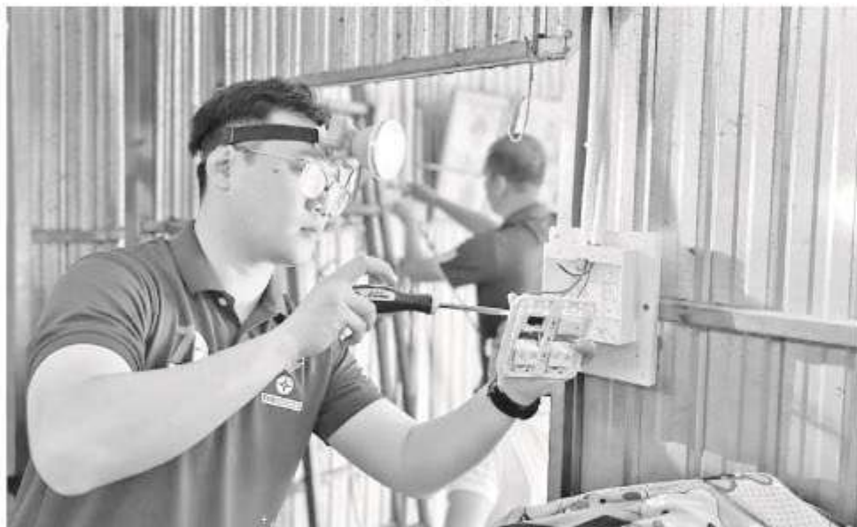
Đoàn viên, thanh niên hỗ trợ người dân cải tạo hệ thống điện, bảo đảm an toàn điện trong sinh hoạt. Ảnh: ĐTN ĐCT
