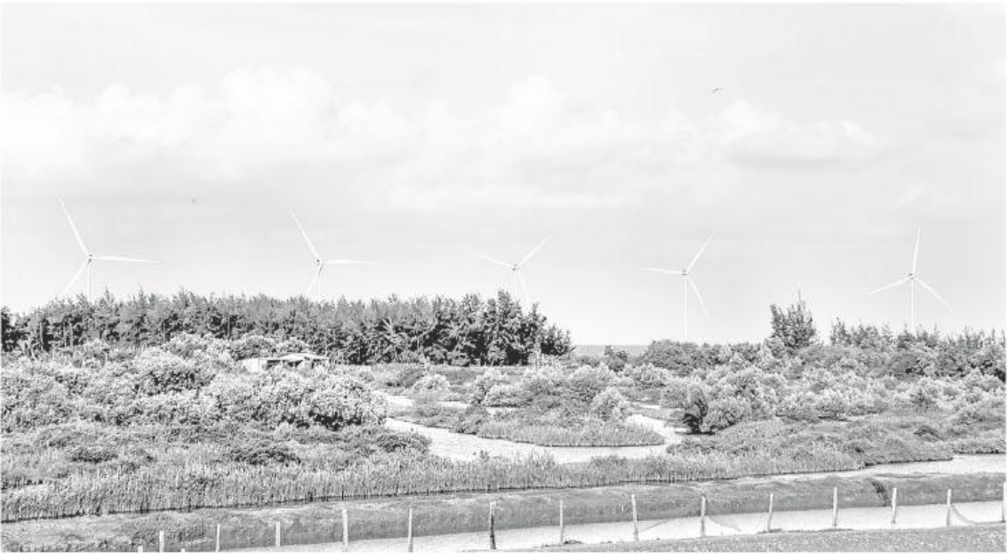
Dự án điện gió V1-3 là dự án điện gió đầu tiên của vùng biển Bến Tre, nay thuộc xã Bảo Thạnh, tỉnh Vĩnh Long, vận hành thương mại vào cuối tháng 11/2021.
