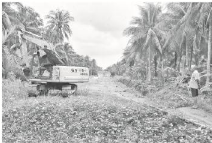
Ông Lâm Văn Xem quan sát công trình thi công trên phần đất vườn được bồi thường giải phóng mặt bằng.
