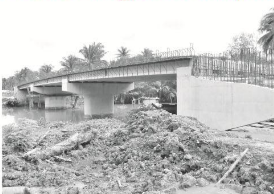
Tiến độ thực hiện công trình cầu Tân Bình đạt trên 90%.
