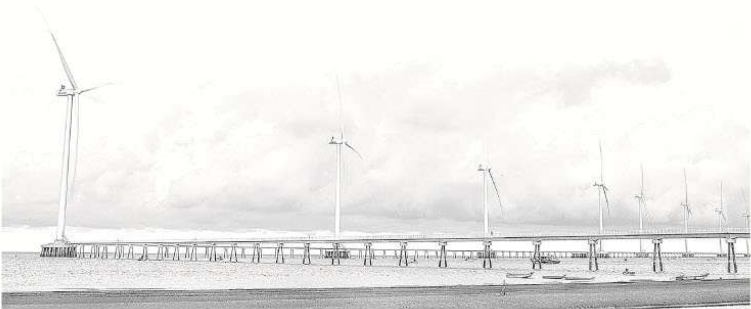
Công trình Điện gió Duyên Hải.
