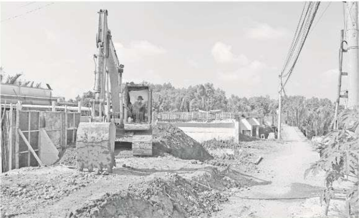
Thi công cầu Rạch Cạn trên tuyến đường ấp Bình Lộc, xã Thạnh Phước. Ảnh: THÀNH LẬP
