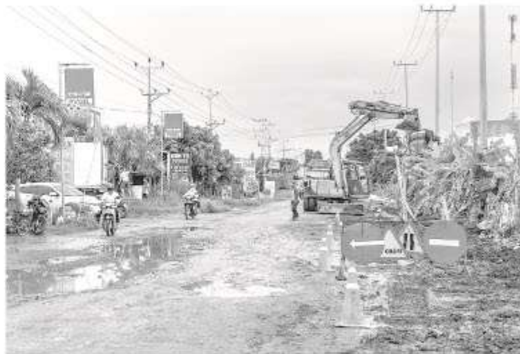
Thi công công trình sửa chữa nền đường và hệ thống thoát nước trên QL57 đoạn qua xã An Qui.
