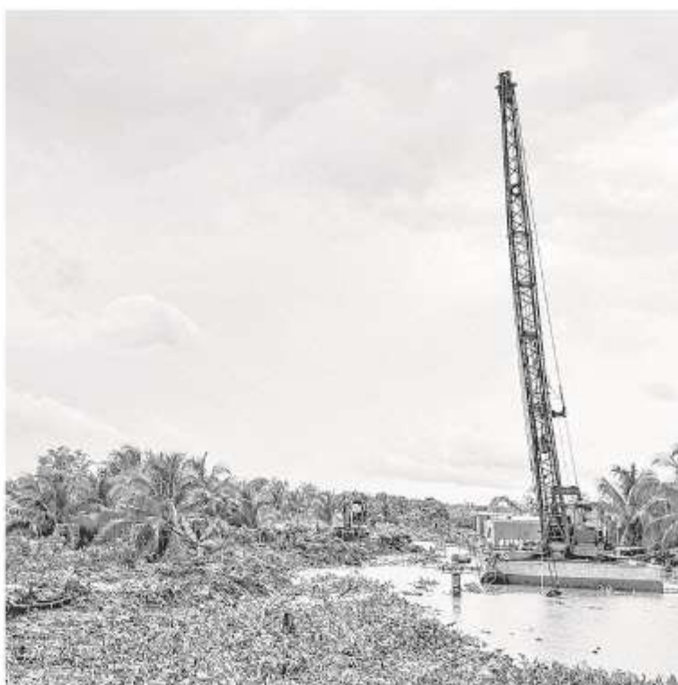
Đơn vị thi công khẩn trương gia cố đê bao tại cồn Cái Gà.
