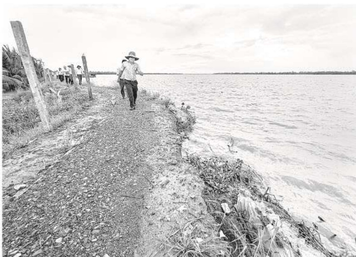
Bờ bao tại cồn Cái Gà cần tiếp tục được theo dõi, gia cố nhằm hạn chế nguy cơ sạt lở, bảo vệ khu vực sản xuất trước triều cường.
