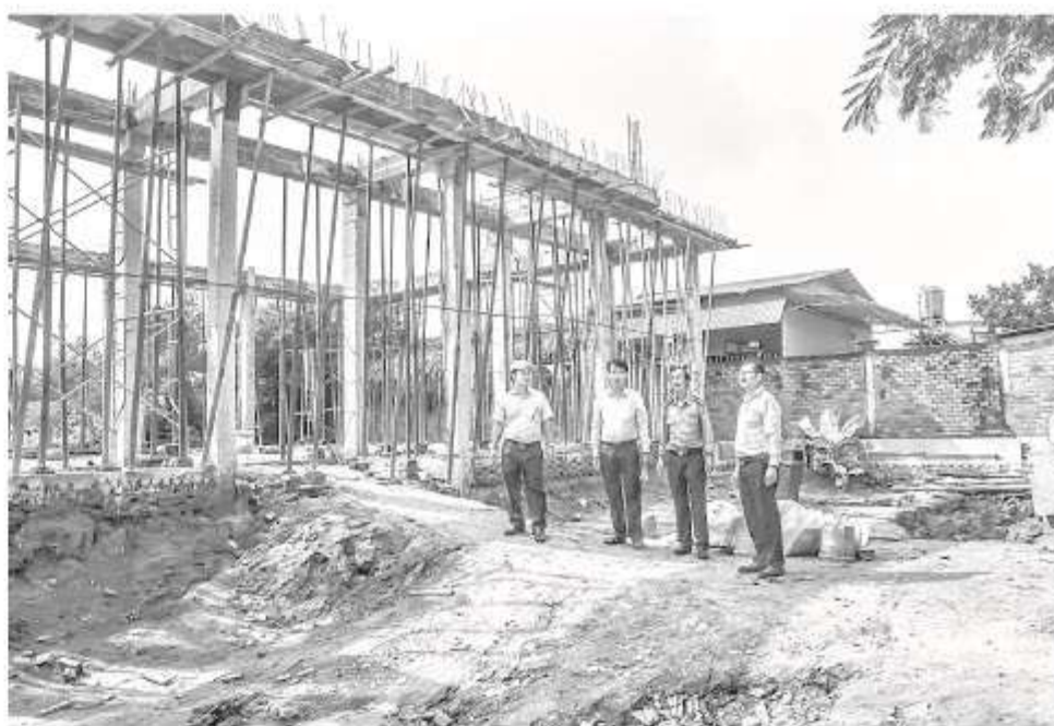
Xã Bảo Thạnh khẩn trương xây dựng trụ sở Nhà văn hóa ấp Thạnh Thới.
