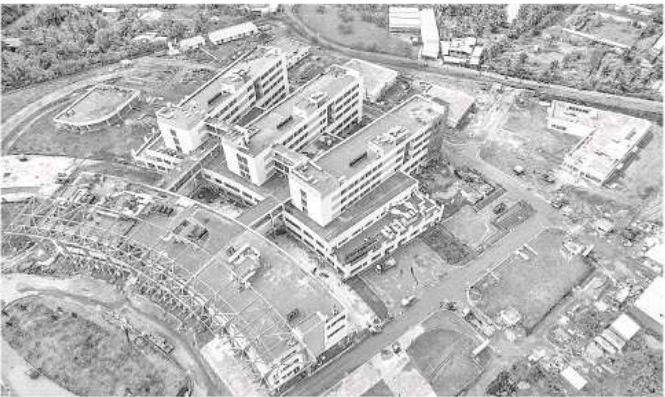
Công trình BVĐK tỉnh Bến Tre đang được tập trung thi công, hoàn thiện.
