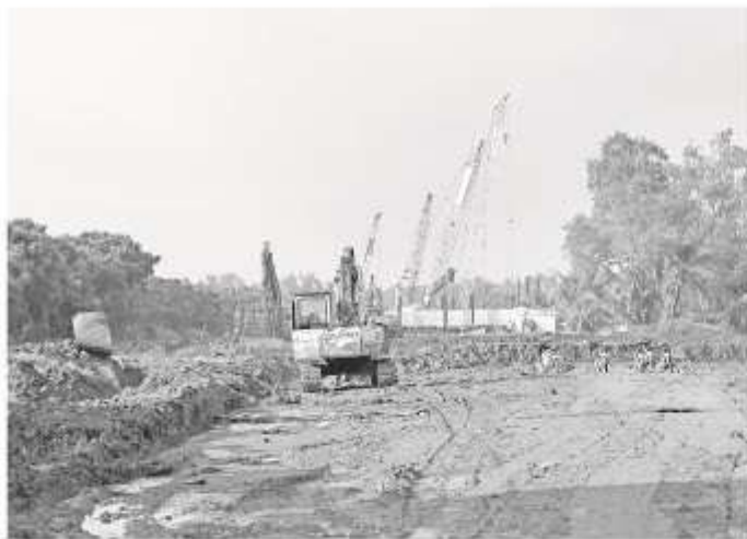
Trên công trường cầu Ba Lai 6.
