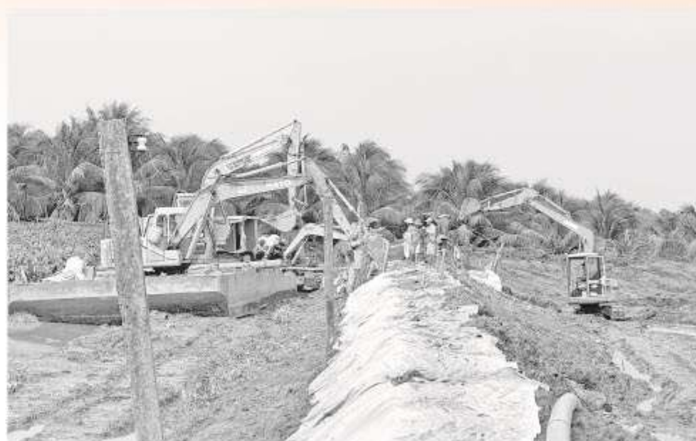
Các lực lượng khẩn trương gia cố điểm đê bao bị sạt lở tại cồn Cái Gà, xã Chợ Lách.
