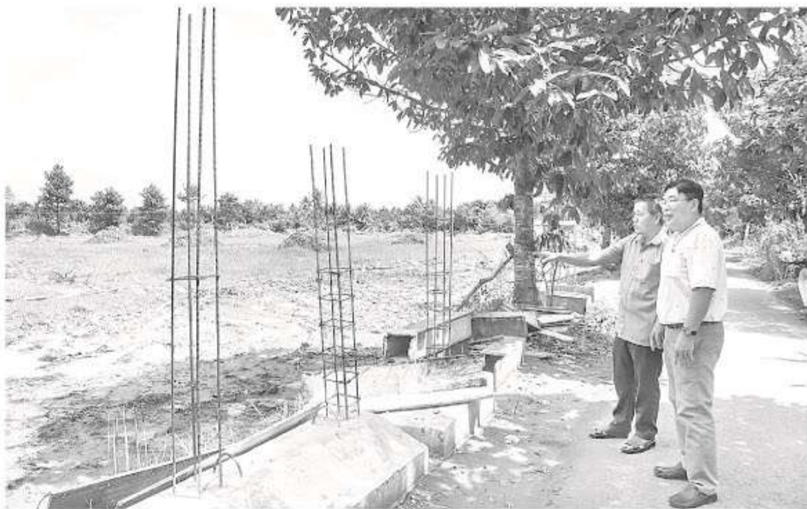
Xây dựng công trình nông thôn mới trên tuyến DX05.
