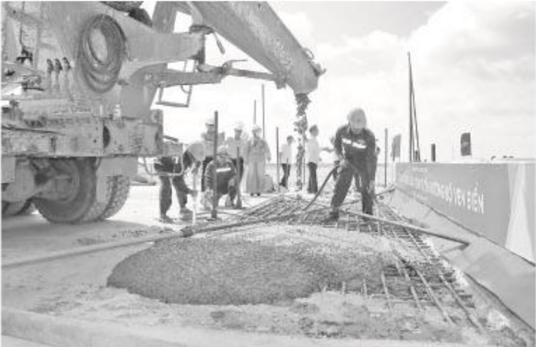
Đẩy nhanh tiến độ các công trình, dự án, góp phần giải ngân vốn đầu tư công. Trong ảnh: Đổ bê tông hợp long cầu Ba Lai 8. Ảnh: THẠCH THẢO
