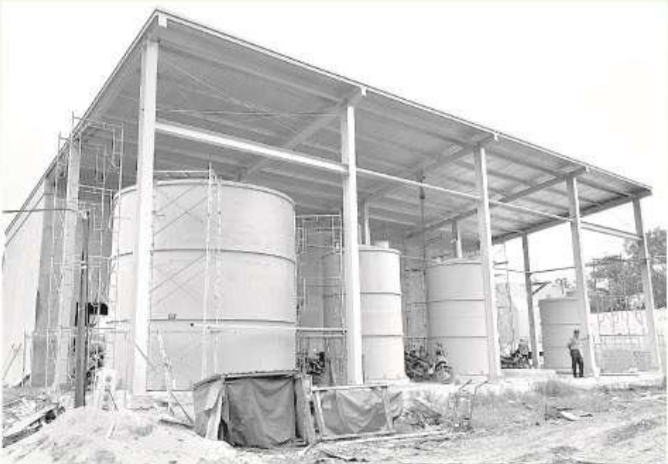
Khu xử khoáng dẫn hoàn thiện.
