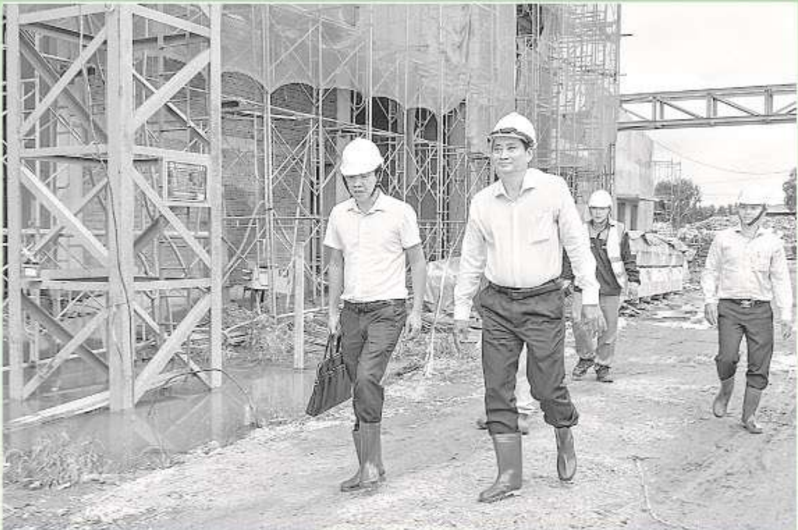
Đồng chí Nguyễn Quỳnh Thiện- Tỉnh ủy viên, Phó Chủ tịch UBND tỉnh kiểm tra tiến độ công trình.
