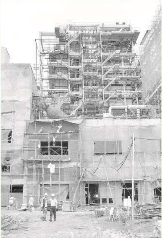
Hệ thống lò hơi với công suất xử lý rác thải sinh hoạt đạt 350 tấn/ngày.
