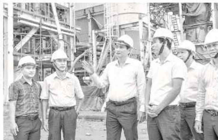
Đồng chí Nguyễn Quỳnh Thiện- Tỉnh ủy viên, Phó Chủ tịch UBND tỉnh khảo sát thực tế tại công trường.
