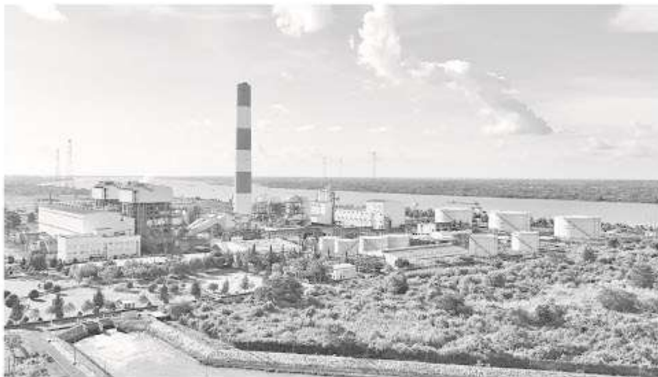
Nhà máy Nhiệt điện Ô Môn I tổng công suất 660MW- Công ty Nhiệt điện Cần Thơ.
