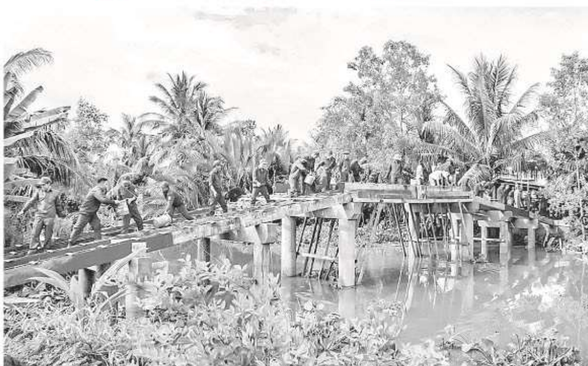
Lực lượng dân quân xã Cái Ngang giúp dân xây dựng cầu nông thôn.
