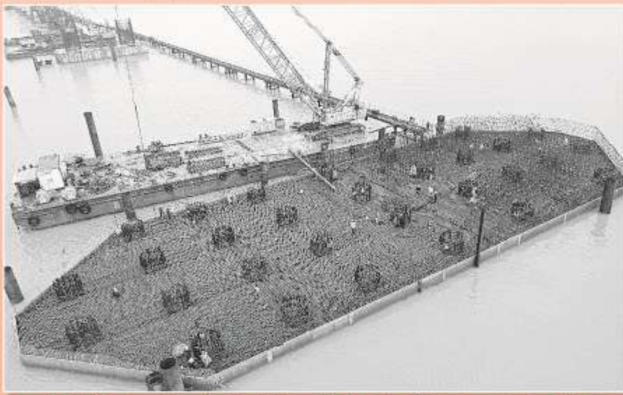
Máy móc thiết bị, công nhân ngày đêm thi đua nhằm đảm bảo tiến độ công trình cầu Đại Ngãi 1.
