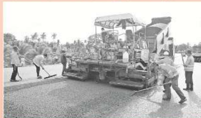
Gói thầu 11-XL, cầu Đại Ngãi 2, tuyến và các công trình trên tuyến, khối lượng thi công đạt hơn 83%.
