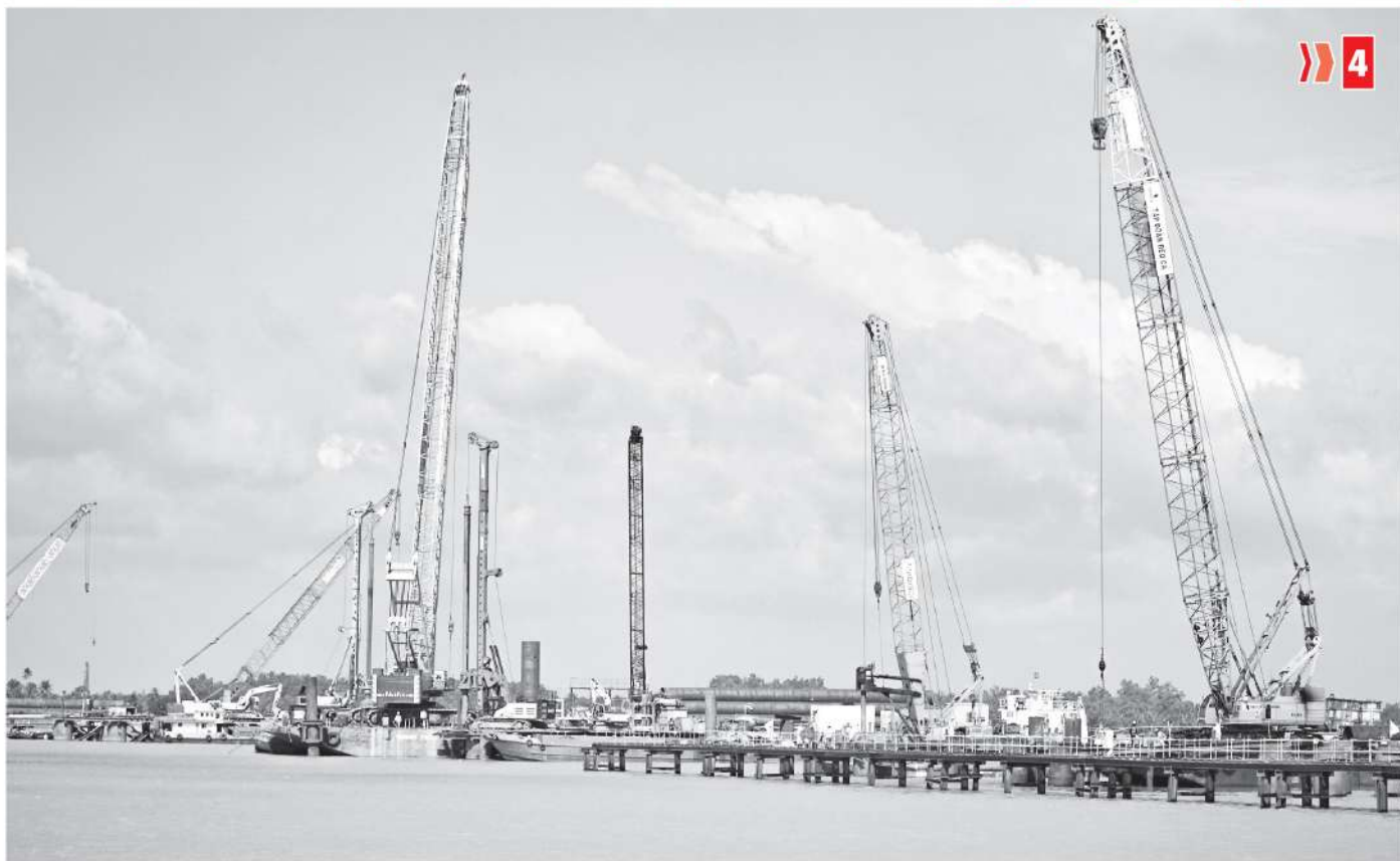
Dự án cầu Đại Ngãi sau khi hoàn thành sẽ góp phần hoàn thiện hạ tầng giao thông phục vụ Khu kinh tế Định An và KCN Ngũ Lạc trong tương lai.
