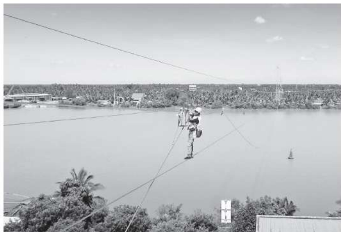
Kéo đường dây 110kV Giao Long - Phú Thuận, vượt sông An Hóa.
