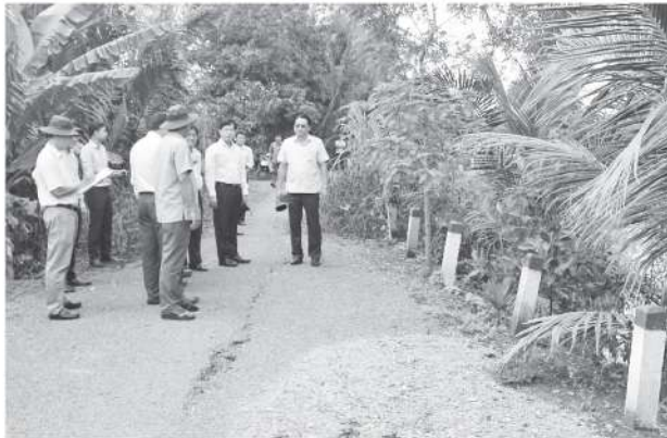
Đoàn công tác khảo sát và đánh giá mức độ nghiêm trọng của các điểm sạt lở tại xã Phong Thạnh.
