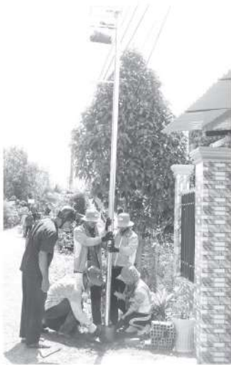
Sinh viên cùng người dân thực hiện công trình thấp sáng tuyến đường quê.
