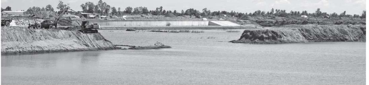
Thi công dự án xây dựng hồ chứa nước ngọt Lạc Địa, xã Tân Xuân.
